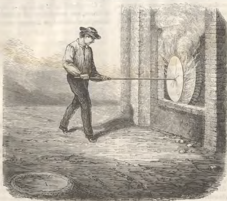
Fig. 36. — Cinquième et dernière forme du carreau de verre par le procédé des plateaux.
