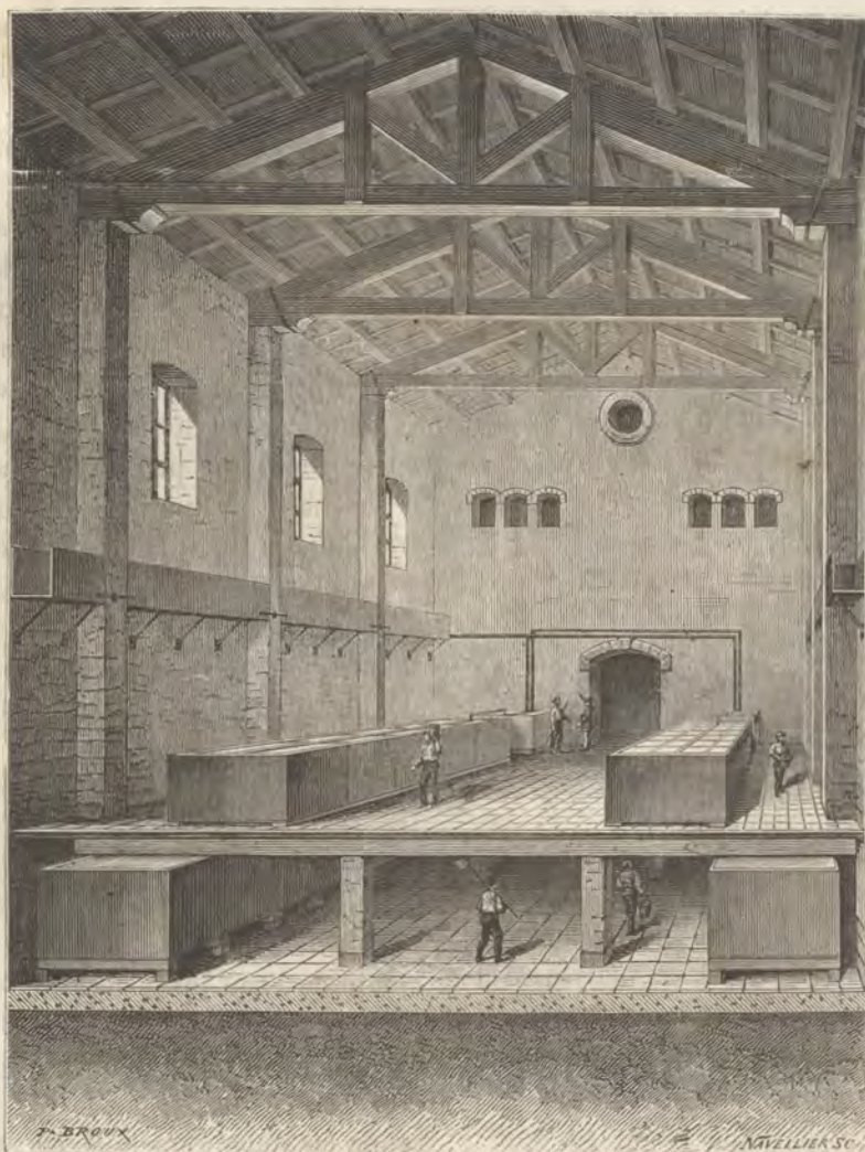
Fig. 218. — Salle des barquieux pour la préparation des lessives de soude, et coupe de la salle des bassines ou récipients des lessives, qui se trouve au-dessous.
