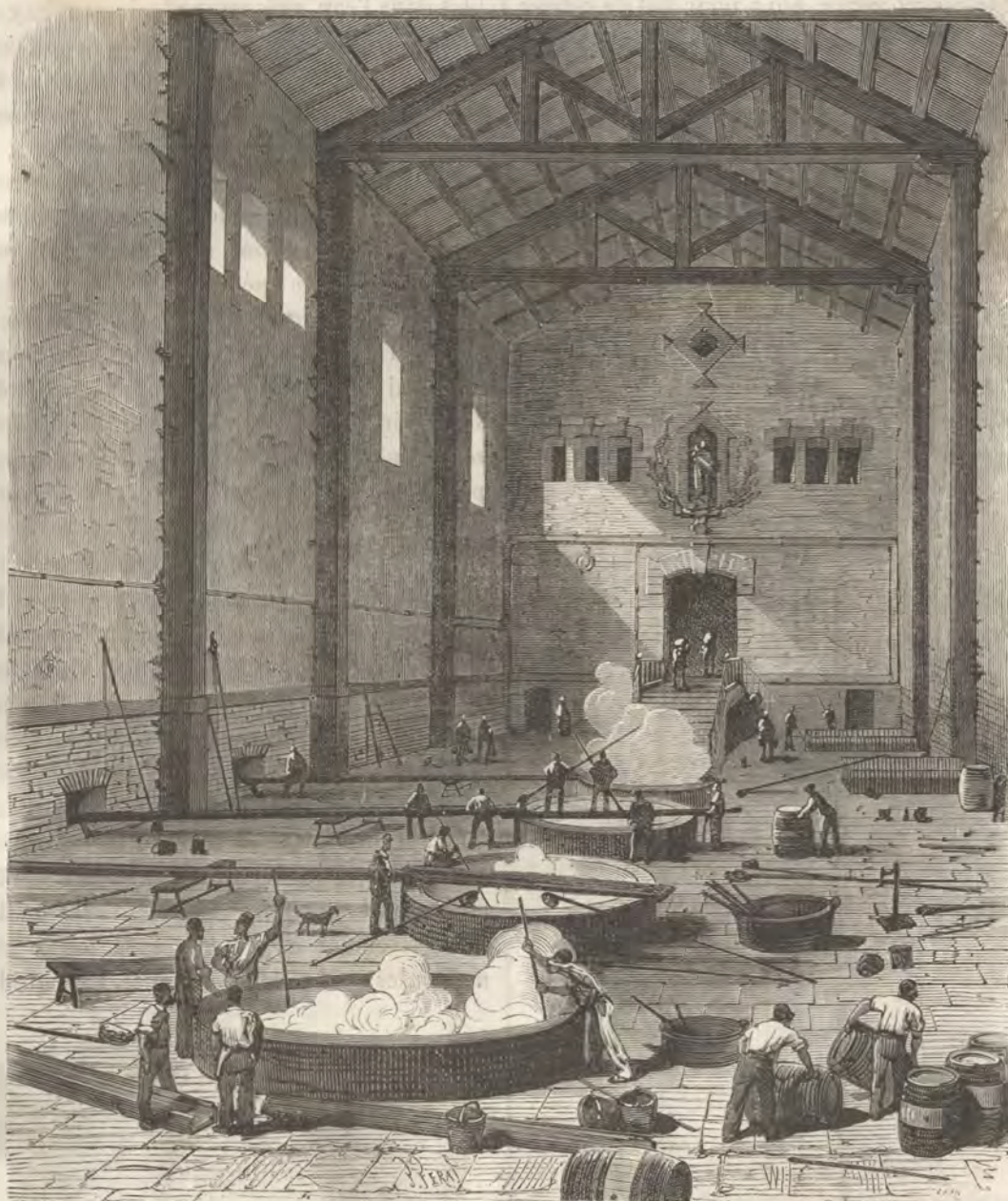
Fig. 286. — Vue générale de la salle des chaudières d'une savonnerie de Marseille. Opération de l'empâtage.
