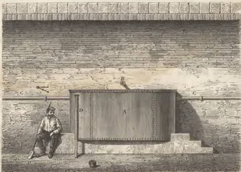
Fig. 291. — Face principale de l'épine ou cuve qui reçoit les eaux arrivant des chaudières.
