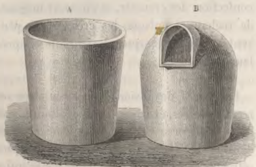
Fig. 17. — Creusets pour le verre à vitres.
