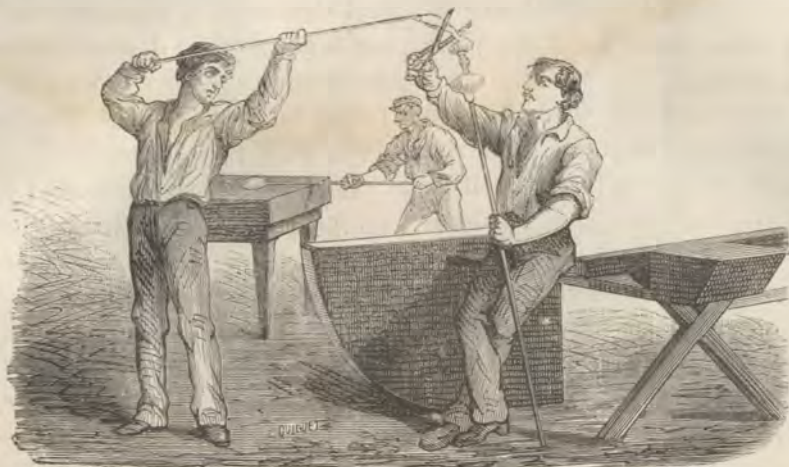
Fig. 78. — Pose de la matière du pied du verre.
