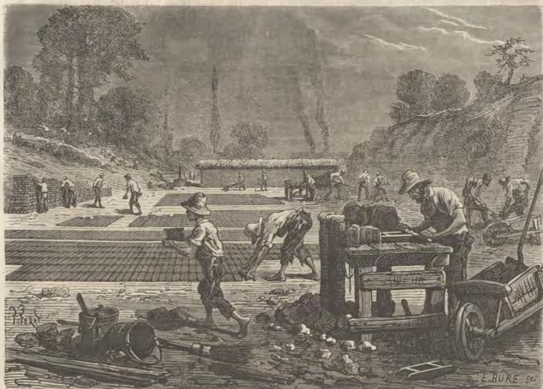
Fig. 252. — Moulage des briques.
