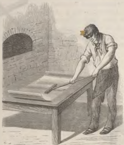
Fig. 30. — Le même planeur achève d'égaliser la feuille de verre avec le polissoir.
