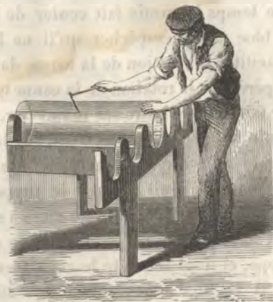
Fig. 28. — L'ouvrier fend le manchon posé sur le chevalet.
